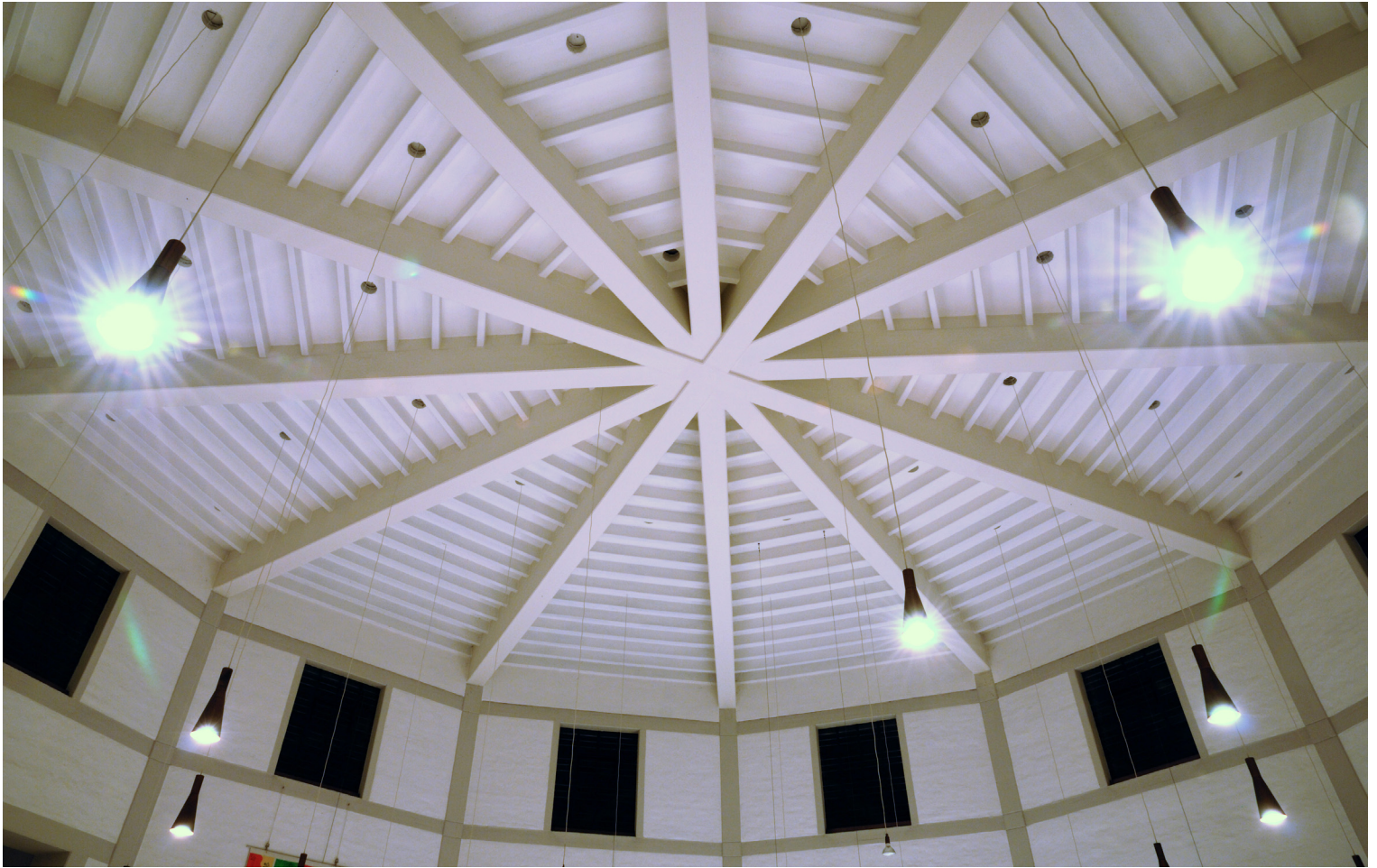
Bild 10 Dachkonstruktion des Kirchenraums
